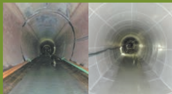
農業用水路トンネルの補修前（左）と補修後（右）。水路トンネル補修工法（パネルライニング工法）により、老朽化したライフラインを低コストで環境に優しくリニューアル。
